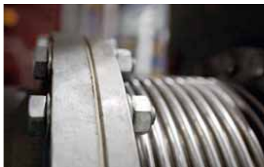
Противозадирная смазка LOCTITE 8150 защищает от схватывания болты крепления расширительных швов на выпускных трубах.
