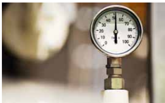
LOCTITE 243 фиксирует и уплотняет нити резьбы термометра на маслопроводной трубке.
