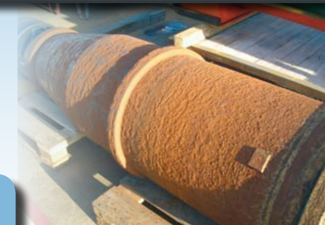
Перед началом ремонта
