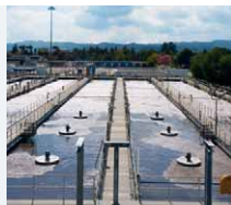
Очистка сточных вод
