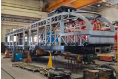
Производственный цех компании Končar Electric Vehicles
